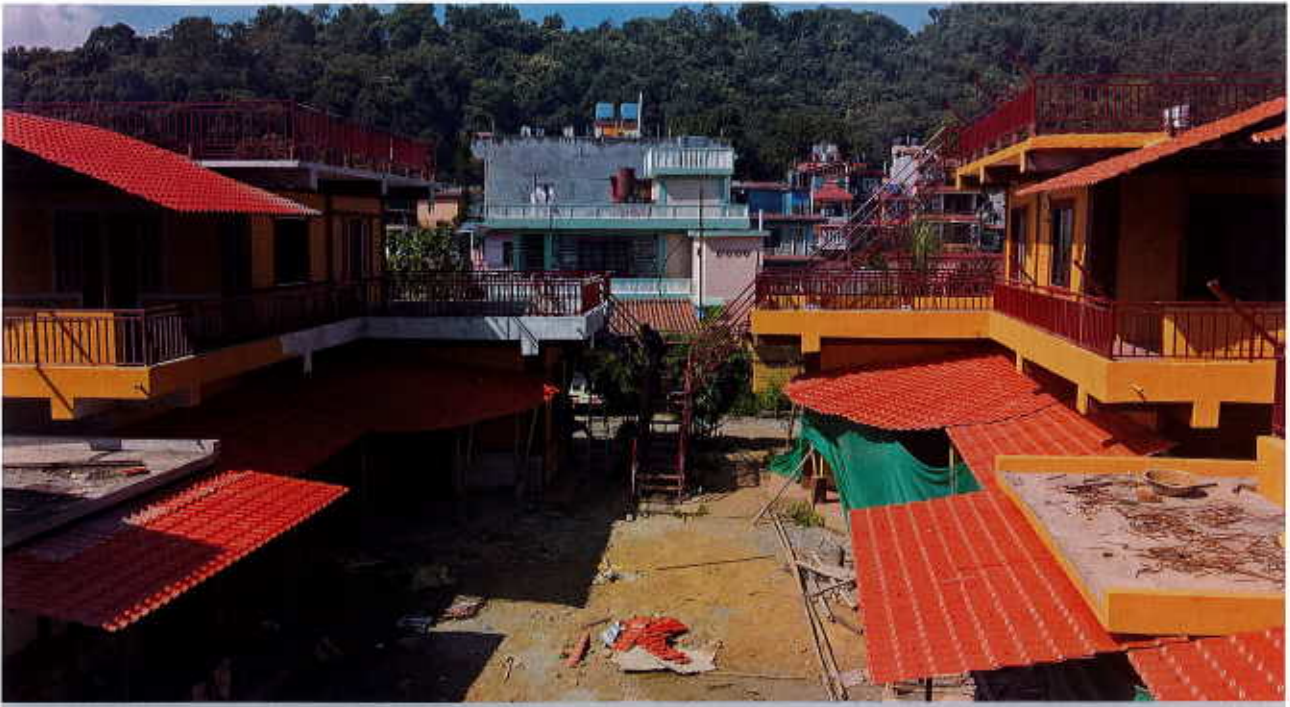
Les maisons entourant le patio
