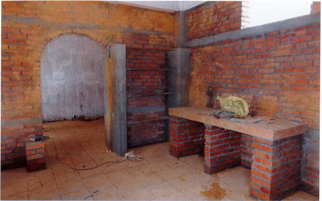
Les aménagements intérieurs
